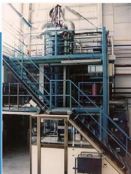
测试工业燃烧器燃烧室
